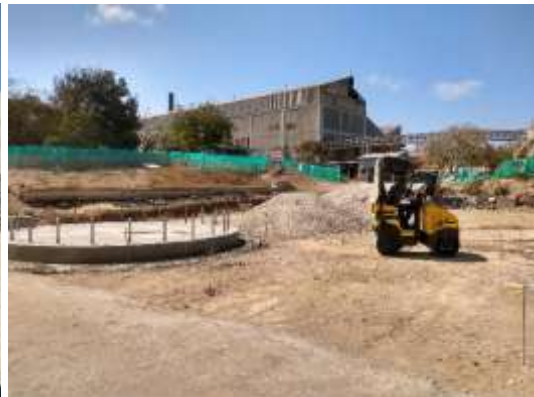
Foto 4. Área en donde se adelanta la construcción de la Planta de Tratamiento de Aguas residuales PTAR
