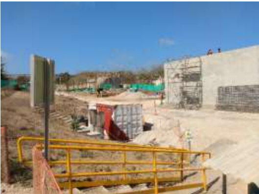
Foto 3. Área en donde se adelanta la construcción de la Planta de Tratamiento de Aguas residuales PTAR
