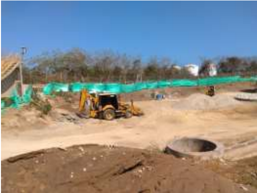
Foto 1. Área en donde se adelanta la construcción de la Planta de Tratamiento de Aguas residuales PTAR
